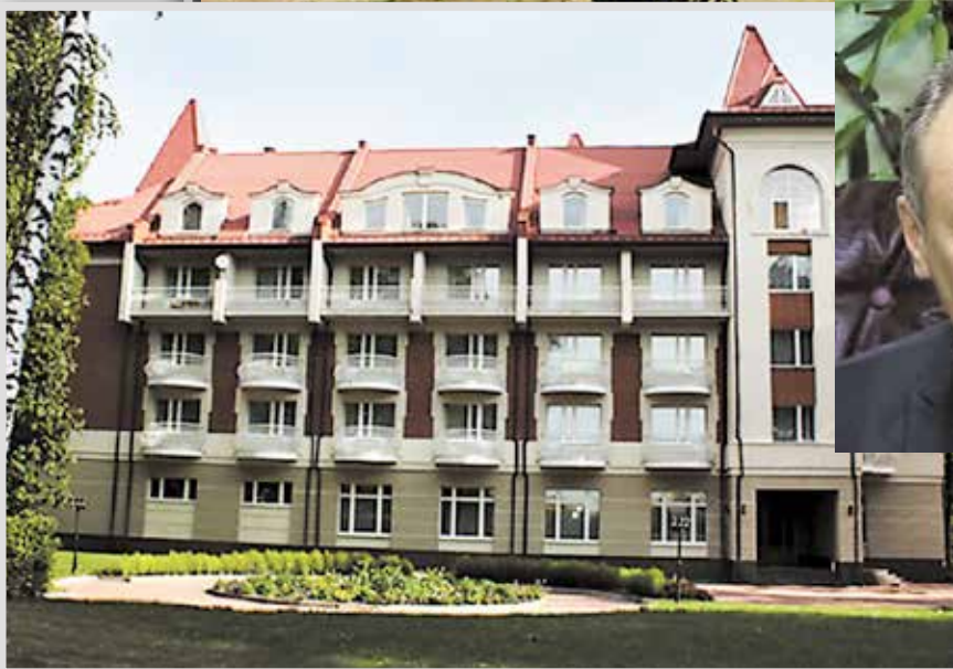
Афанасьев следит за тем, чтобы блеск «губернаторского» корпуса не тускнел на фоне старых зданий «Дубравы»?
