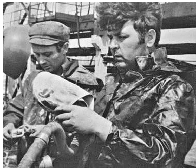
Иосиф Душанек на строительстве ПК «Шесхарис».
